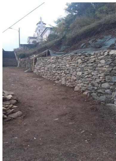
prima settimana è stato avviato, come campo scuola, il cantiere per il ripristino del muro di contenimento a monte della strada di accesso alla chiesa di San Martino dopo il Ricovero per
