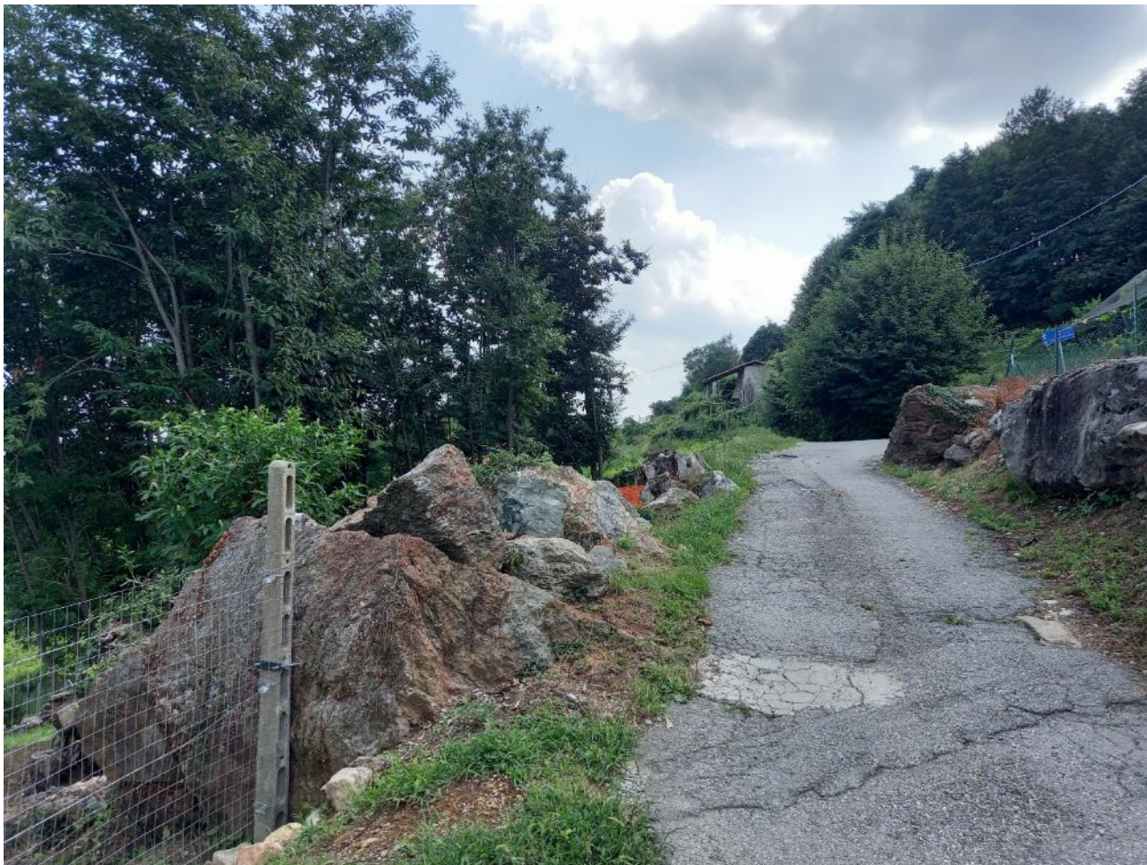
Figura 32: Manto stradale fortemente degradato con evidenti segni di cedimento sul lato di valle.
