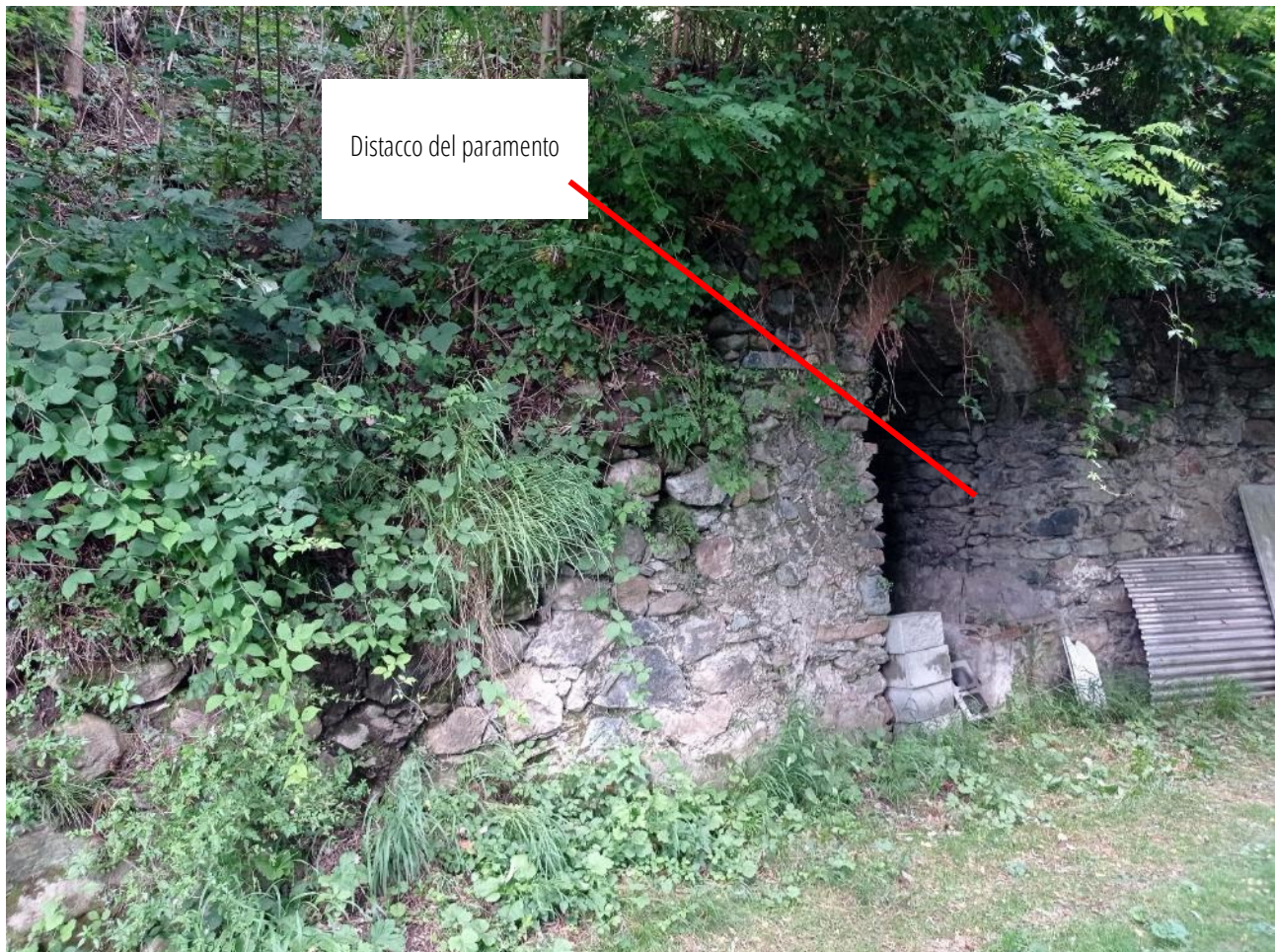
Figura 27: Evidenza di dissesti all'interno del locale ricavato a tergo del muro
