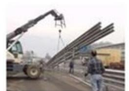
Solitamente lo stesso autocarro adibito al trasporto materiali è equipaggiato di gru idraulica di servizio: tutti i componenti vengono scaricati a terra e distribuiti lungo la linea di posa.
