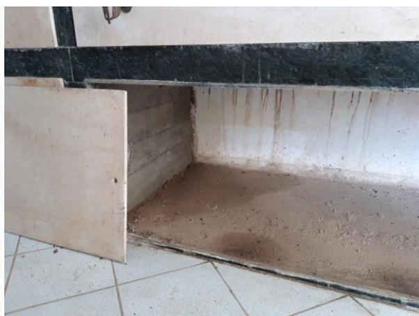
Tali divisori, da realizzarsi in blocchi di calcestruzzo cellulare, serviranno all'ancoraggio (meccanico e chimico) delle lastre di rivestimento verticali, da realizzarsi in marmo "Verde di Gressoney".
